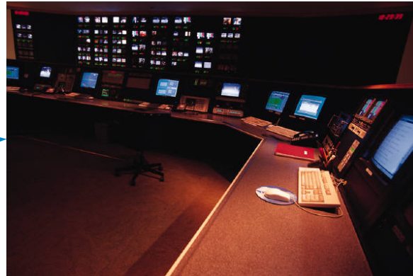
Système Numérique de Contrôle Commande
